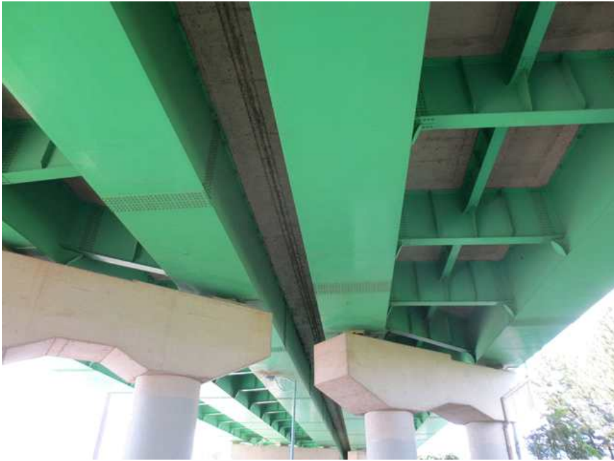
바닥판하면 및 강박스 외부전경
